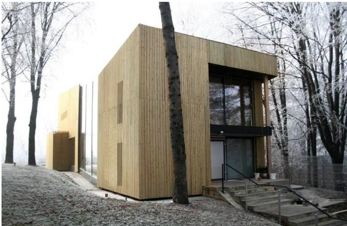
Figura 3. Casa Pasivă Che situată în județul Suceava.
